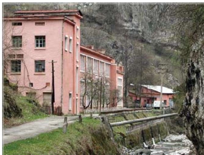
Фото 2. Гизельдонская ГЭС Photo 2. Gizeldonskaya HEPS
