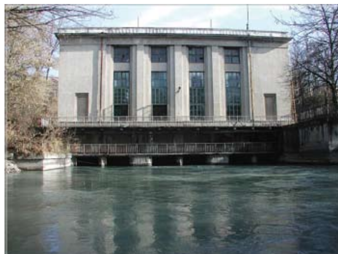
Фото 3. Дзауджикауская ГЭС Photo 3. Dzaujkauskaya HEPS
