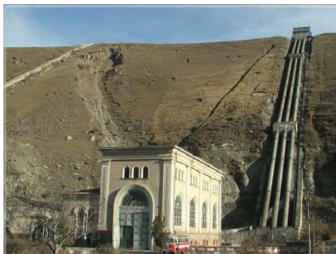
Фото 1. Эзминская ГЭС Photo 1. Ezminskaya HEPS
