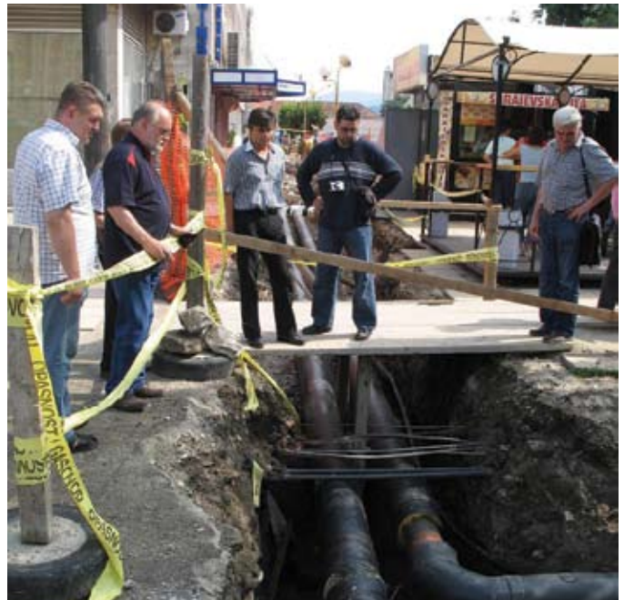
Иллюстрация 2: Вели-Матти Кивистё (второй слева) контролирует прокладку сетей ЦО и подчеркивает важность соответствующего надзора на участке работ.
