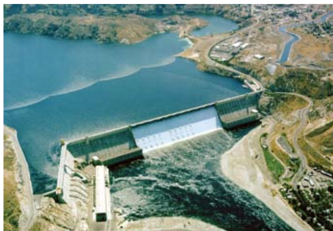
Рис. 1: Плотина Гранд-Кули на реке Колумбия в штате Вашингтон (США): 6809 МВт установленной мощности генерирования, 3x605 МВт и 3x805 МВт на Третьей ГЭС
