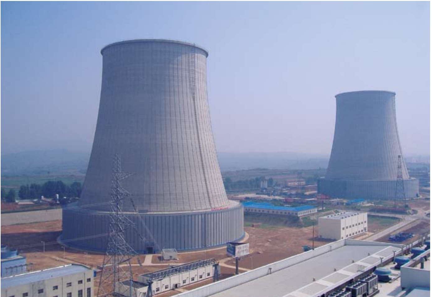
Рис. 3: Градирни сухого охлаждения на угольной ГРЭС мощностью 2 x 600 МВтэ в Яангшэнь, Китай (Собственник: Datang Int.)
