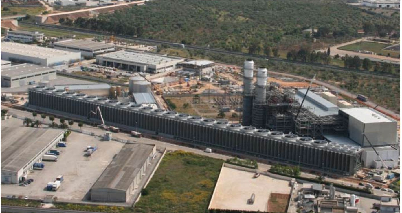
Рис. 6: ТЭС в Модуньо, Италия (мощность 800 МВтэ) оборудована системой Геллера с принудительной тягой. (Собственник: Energia SpA; контракт на EPC: Alstom)
