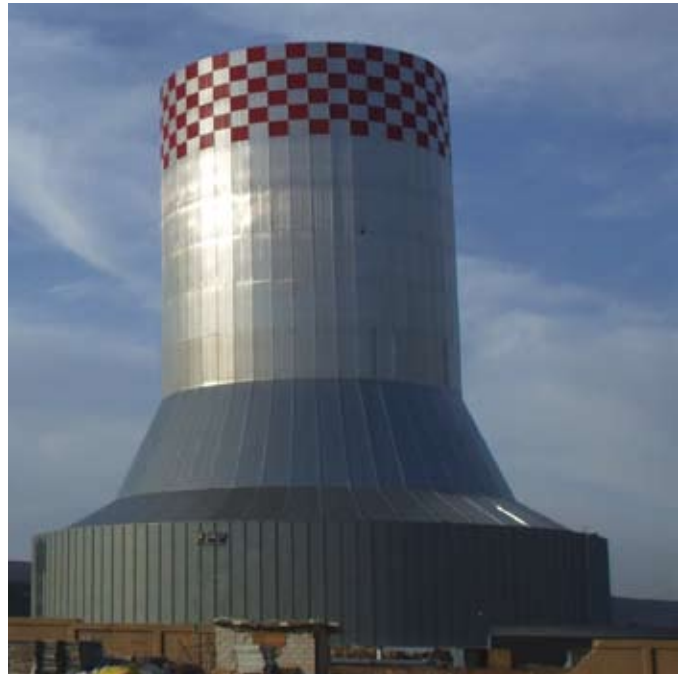
Рис. 4: Стальная градирня, обшитая алюминиевыми листами в знойной пустыне. ГРЭС мощностью 750 МВтэ в Дейр-Али, Сирия. (Собственник: PEEGT; контракт на EPC: Siemens)
