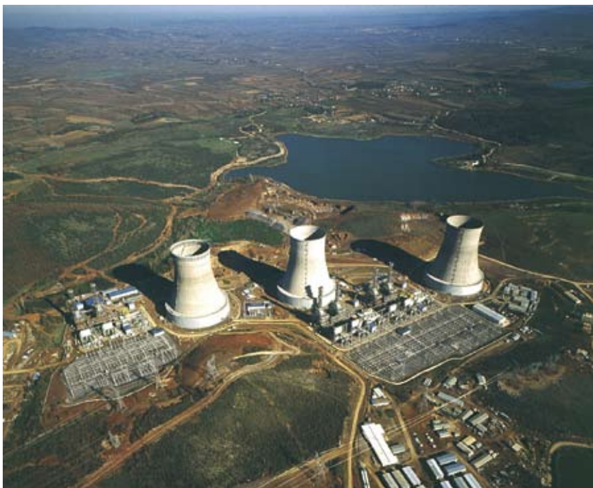
Рис. 1: Самая большая в мире электростанция комбинированного цикла с системой сухого охлаждения: Мощность: 3 x 800 тыс. МВтэ Гёбзе и Адапазары, Турция (Собственник: Interger/Enka; контракт на EPC: Bechtel/Enka)
